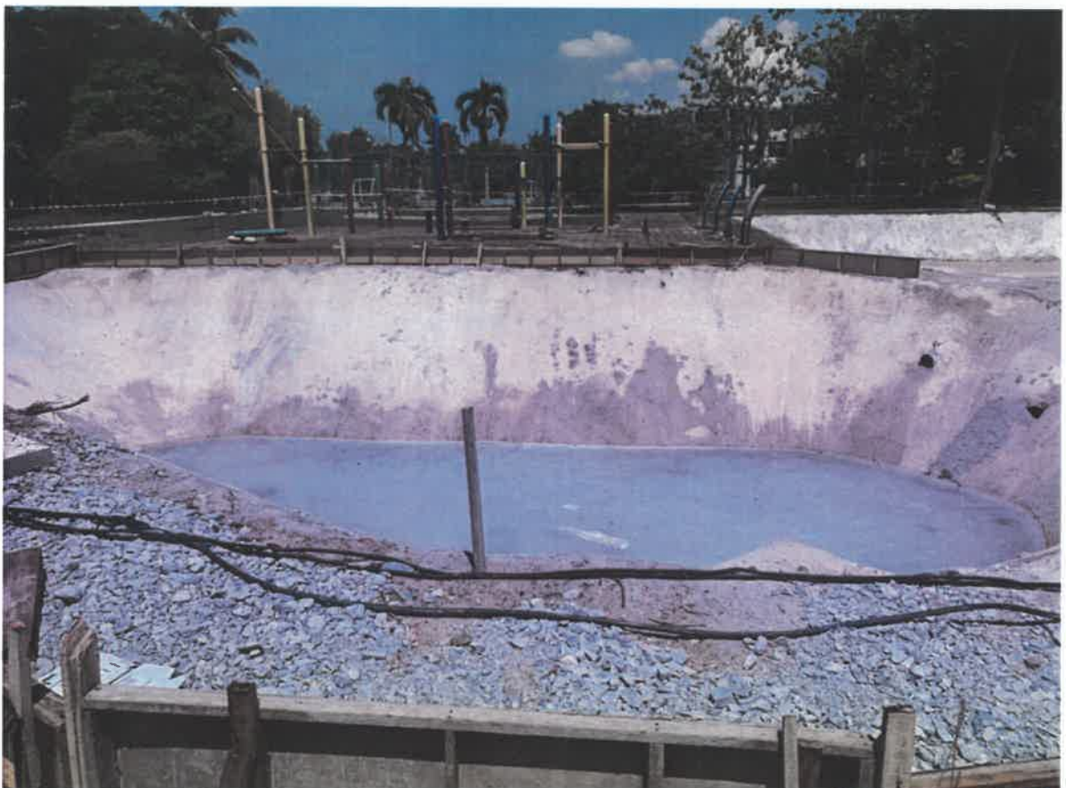
GAMBAR PEMBINAAN KOLAM TADAHAN ( IL 3.30M)
