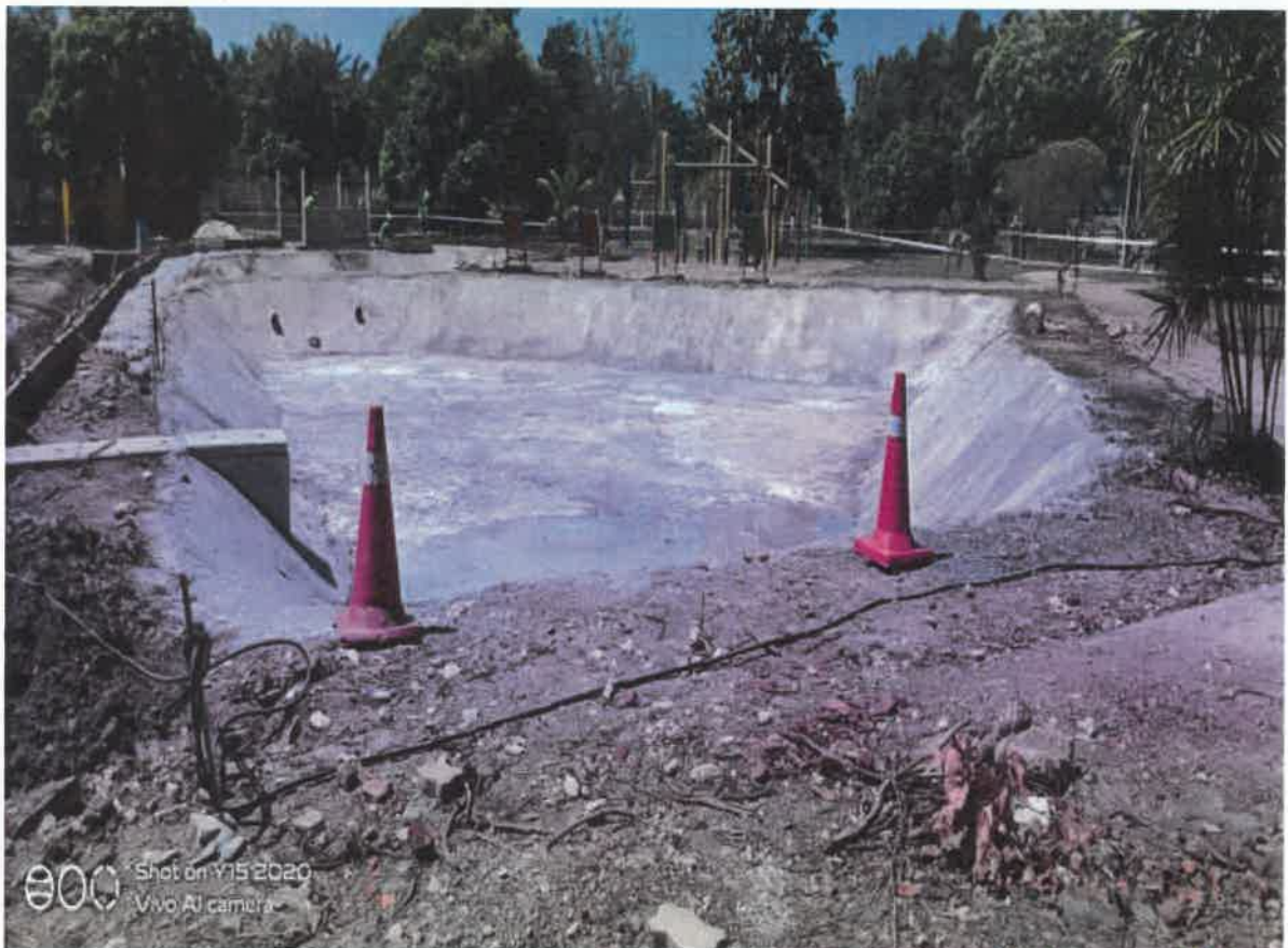
GAMBAR PEMBINAAN KOLAM TADAHAN (IL 1.50M)
