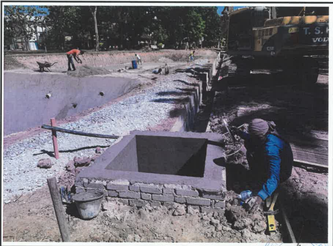
GAMBAR PEMBINAAN LONGKANG U-DRAIN DAN TAKUNGAN KONKRIT
