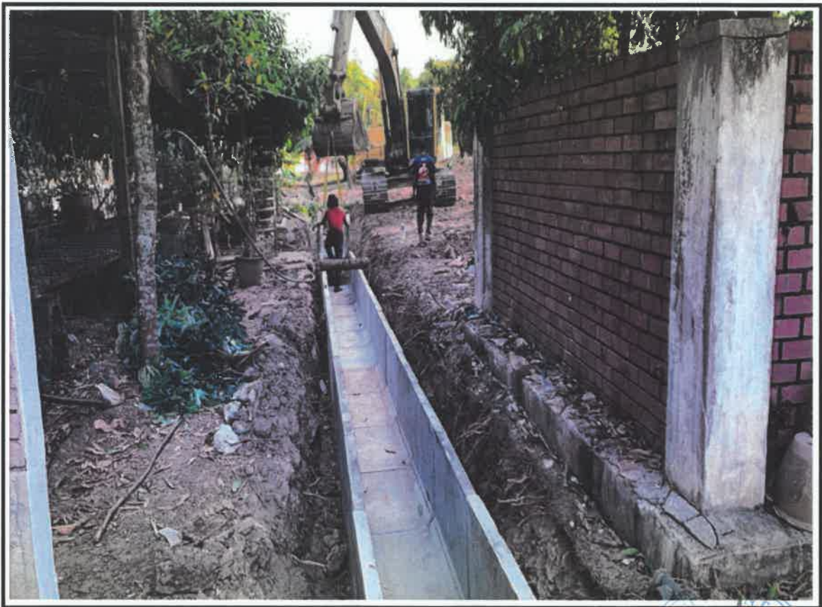
GAMBAR PEMBINAAN LONGKANG U-DRAIN
