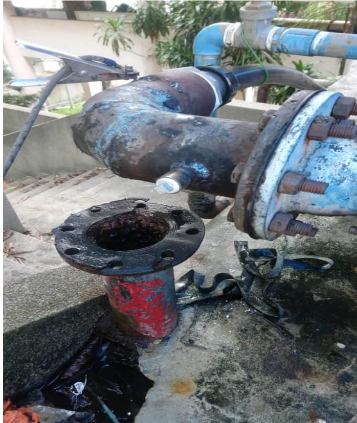
GAMBAR DIATAS : Penutup ulir skru baru dengan kemasan welding
