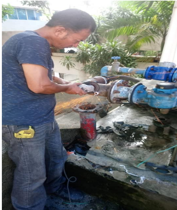
GAMBAR DIATAS : Grinding (memotong lebihan paip bocor)
