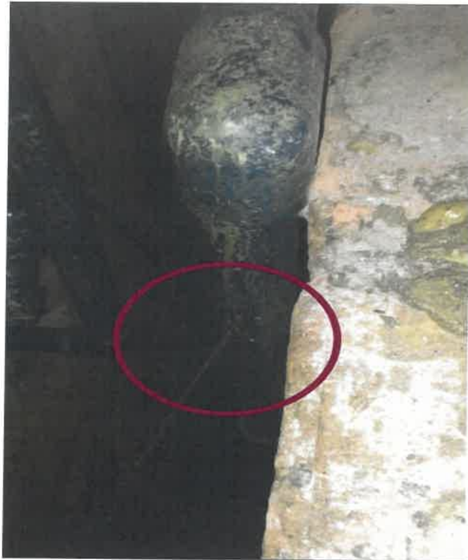
GAMABAR DIATAS: Kebocoran paip ABS di dalam siling tandas wanita (W) tingkat 2 Blok Inovasi
