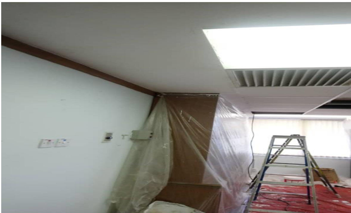
Gambar diatas : siling yang telah diganti baru dan dicat putih
