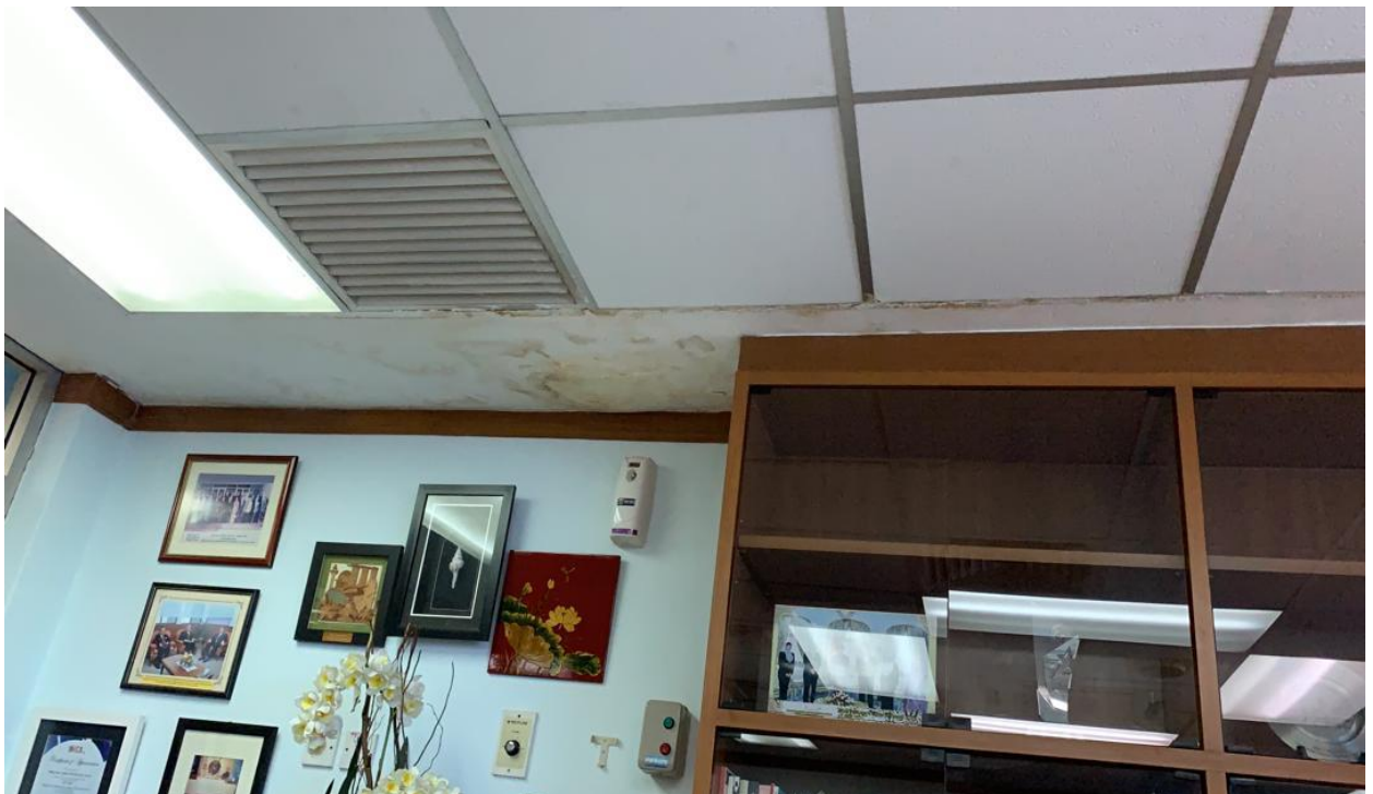
Gambar Di atas: Siling akan ditukar selepas kerjakerja PU Grouting dilakukan
