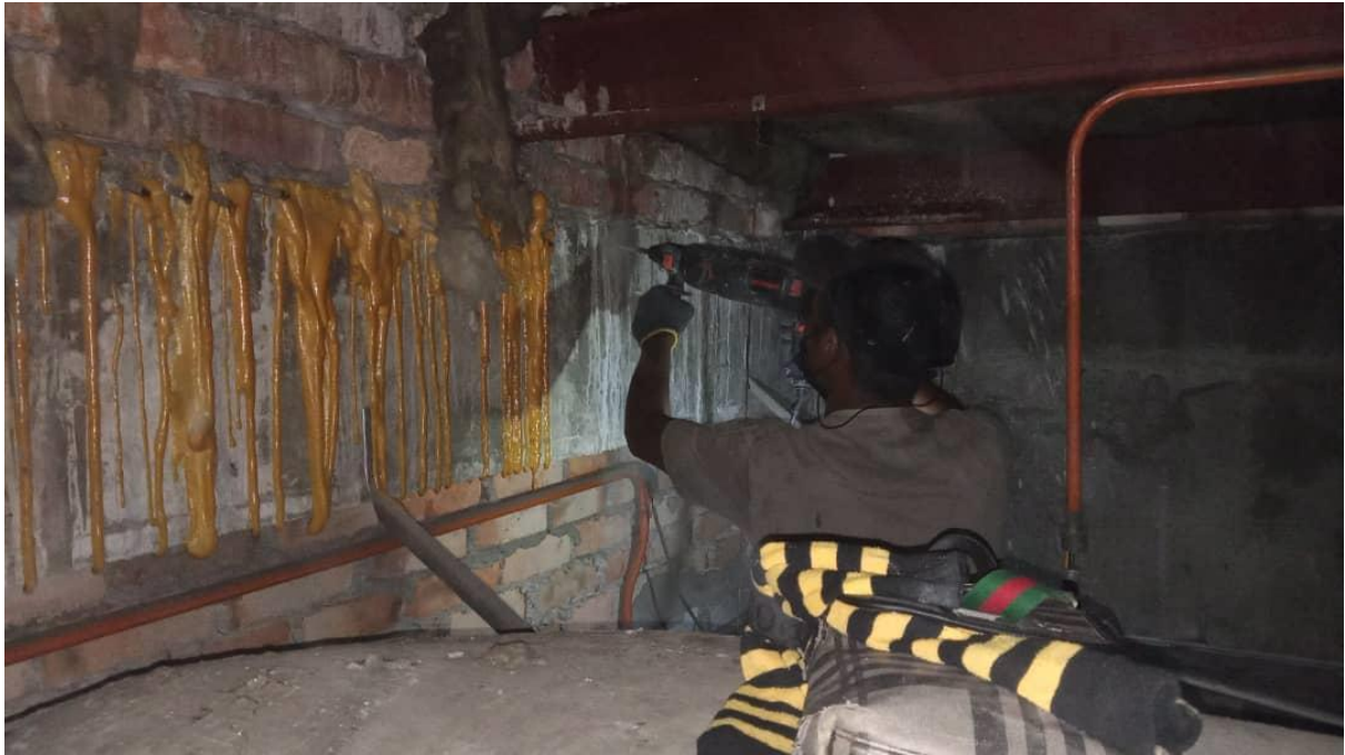
Gambar diatas : Kerja – kerja gerudi untuk 22 point di dinding lokasi kebocoran tersebut
