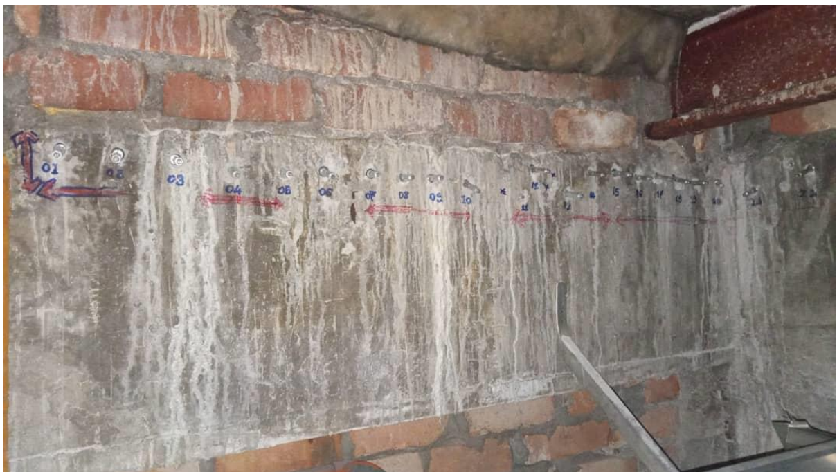
Gambar diatas : lokasi 22 point yang telah siap digerudi dan dipasang Filing Pin
