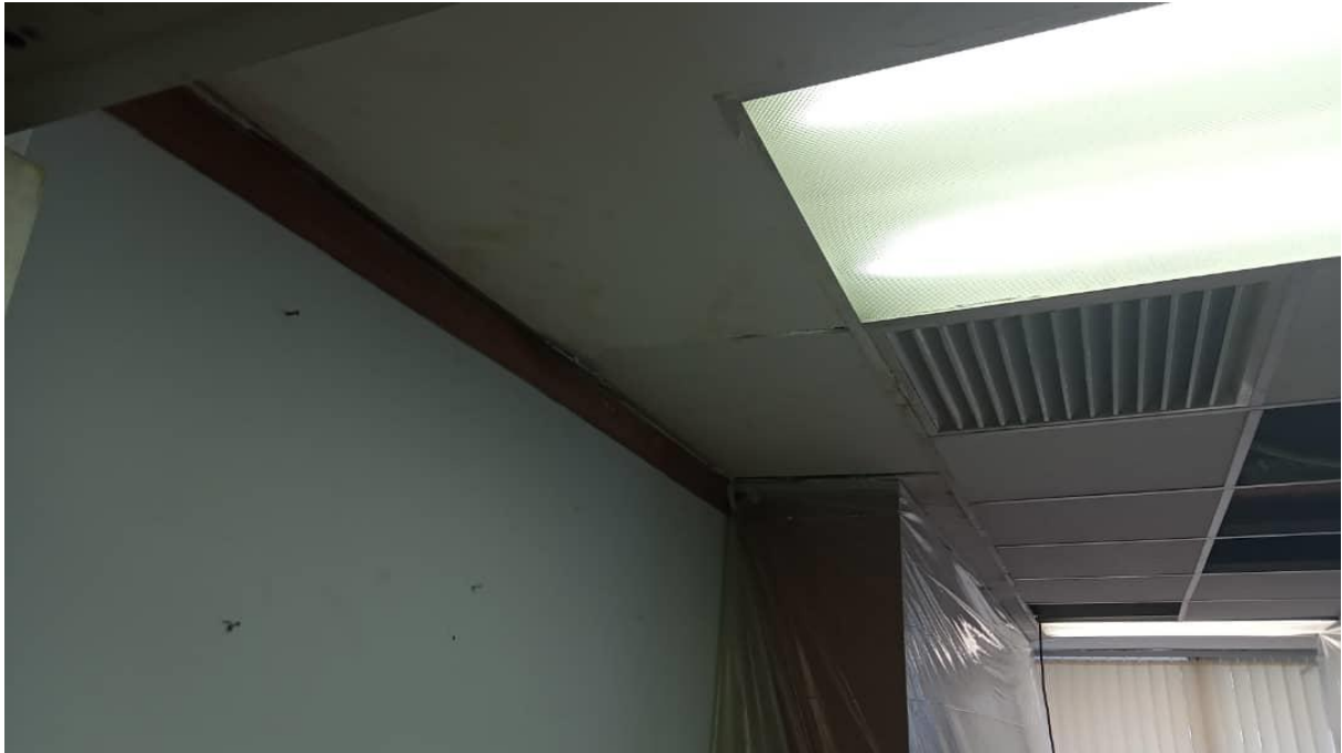
Gambar diatas : kerja – kerja penggantian siling rosak
