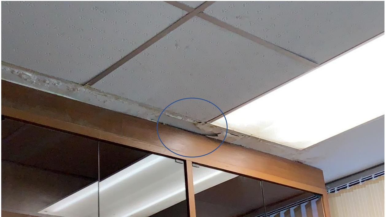
Gambar diatas: Lokasi baru kesan air menitik daripada siling
