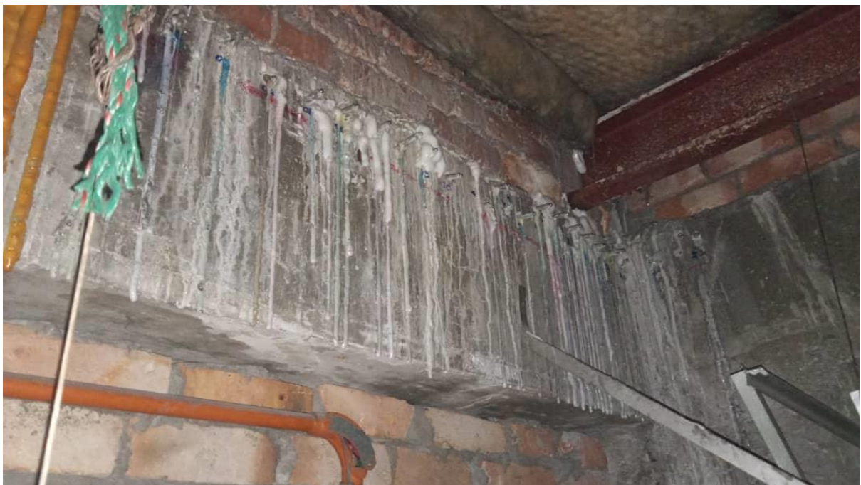
Gambar diatas : kerja – kerja pump tersebut selesai untuk 22 point
