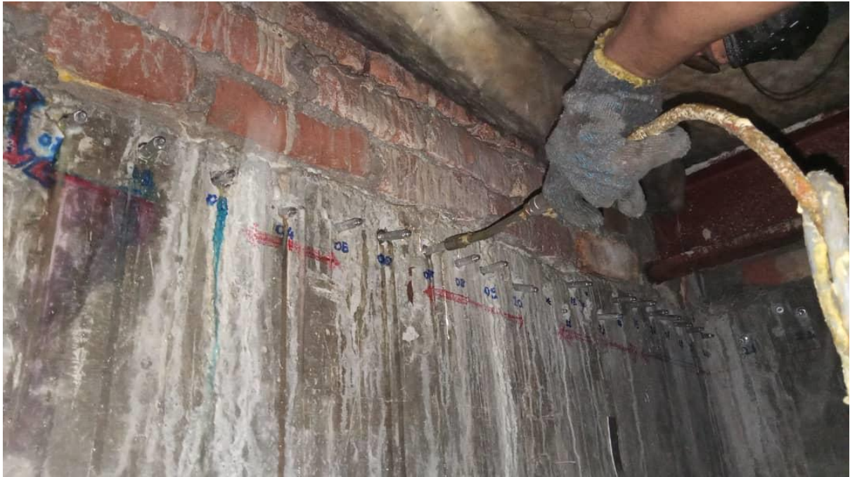
Gambar diatas : kerja – kerja pump poly cell foam untuk menghentikan kebocoran air
