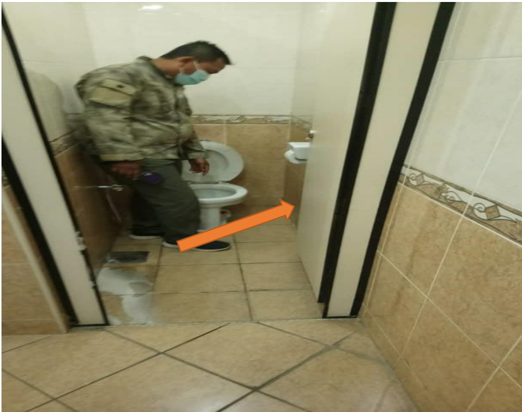
GAMBAR DIATAS : Pengesahan Akhir untuk kerja baik pulih di tandas lelaki (seperti di anah panah)
