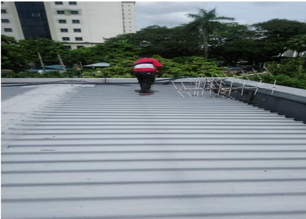
GAMBAR DIATAS : Pengukuran bumbung lama (diatas bilik PA Pool) untuk penambahan bumbung baru selepas ini.
