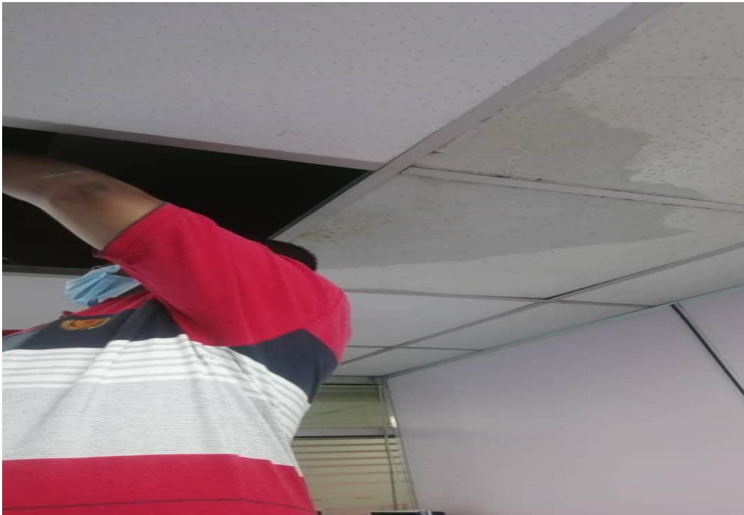
GAMBAR DIATAS : Keadaan Siling yang lembab & berair serta punca kebocoran sedang dikenalpasti oleh pihak kontraktor
