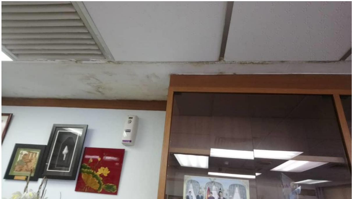
GAMBAR DIATAS : Siling gelembung akan ditukar selepas kerja Grouting dilakukan
